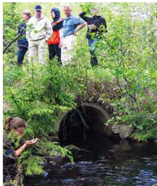
Figur 53. Felaktigt placerad vägtrumma som utgjorde vandringshinder vid lågvatten i Lillsjöbäcken, Örebro län (Life-vattendrag). Genom att lägga stora stenar nedströms och tät med geotextil höjde Urban Hjalte och Peter Johansson vattennivån. Två trösklar anlades så att en successiv höjning erhöles. Foto: Thomas Nydén, Sofi Alexanderson
