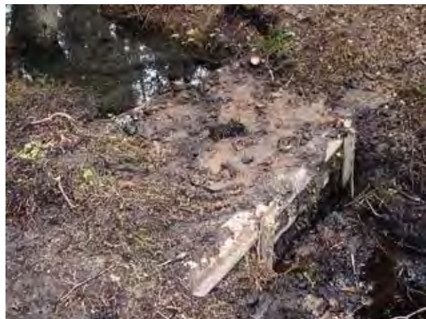
Figur 34. I WWFs och Sveaskogs demonstrationsprojektet Gallåsen, Västra Götaland, har 2,2 kilometer diken dämmts manuellt eller med grävmaskin eller skotare (bilden). Detta resulterade i 5 hektar skogliga våtmarker och förbättrad vattenkvalitet nedströms. Foto: Per Peterson
