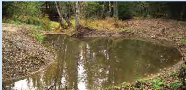
Figur 32. En anlagd sedimentationsfälla i form av en slamgrop i ett litet dike som mynnar i flodpärlmusselvattendraget Brånsån. Utforma botten så att den är lätt att tömma med grävmaskin. Kostnad cirka 5 000 kronor. Foto: Håkan Söderberg
