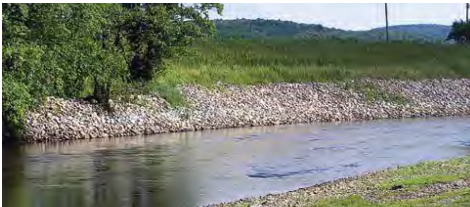
Figur 41. Strandskoning i en del av Viskan minskar dels rasrisken i området och dessutom minskar sedimenttransporten i vattendraget. Observera att naturlig erosion skall tillåtas. I vattendraget finns flodpärlmusslor både upp- och nedströms. Foto: Erik Degerman
