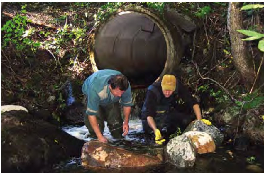
Figur 53. Felaktigt placerad vägtrumma som utgjorde vandringshinder vid lågvatten i Lillsjöbäcken, Örebro län (Life-vattendrag). Genom att lägga stora stenar nedströms och tät med geotextil höjde Urban Hjalte och Peter Johansson vattennivån. Två trösklar anlades så att en successiv höjning erhöles. Foto: Thomas Nydén, Sofi Alexanderson
