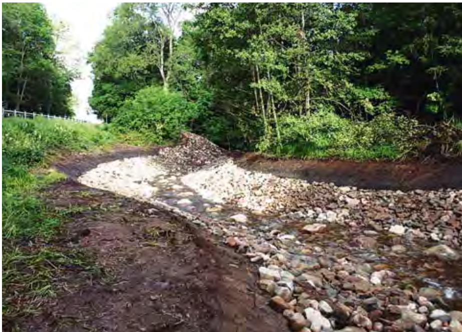
Figur 52. En fåra har skapats genom de gamla sedimentlagren i dammens botten. Sedimenten stabiliseras, liksom fåran. Snart kommer vegetation att täcka sedimenten som därvid stabiliseras ytterligare. Foto: Erik Degerman
