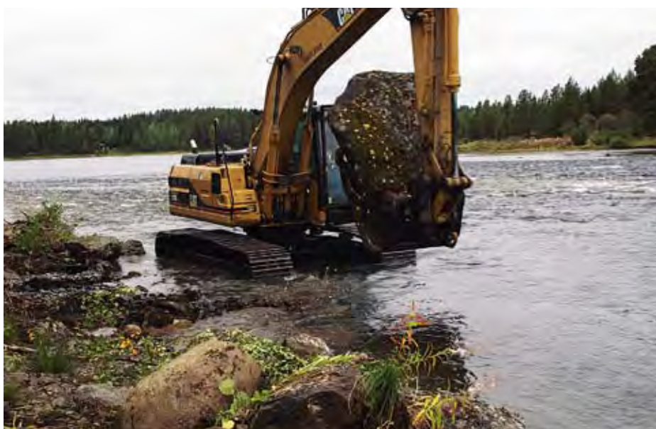
Figur 46. Biotoprestaurering i Härkan, Jämtland, där syftet var att återföra de stora block som lyfts och sprängts bort för att underlätta för flottning. Stora stenar i strandkanten lyfts ut i vattendraget med grävmaskin. Foto: Erik Degerman
